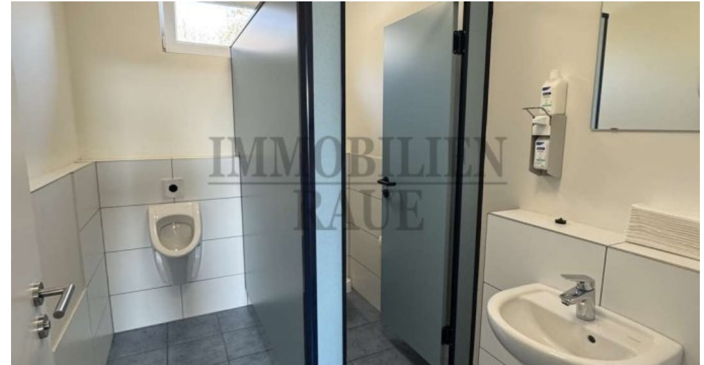
1. OG Herren WC-Anlage
