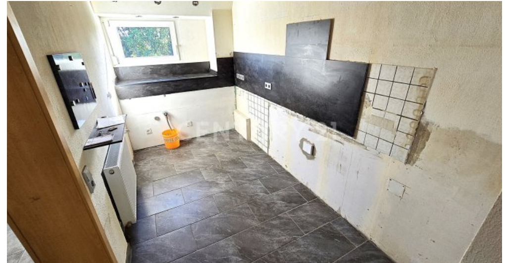
Küche der Wohnung im Obergeschoss
