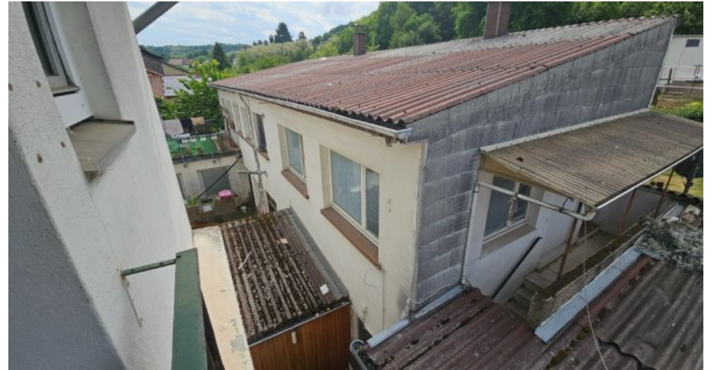
Blick auf das Hinterhaus
