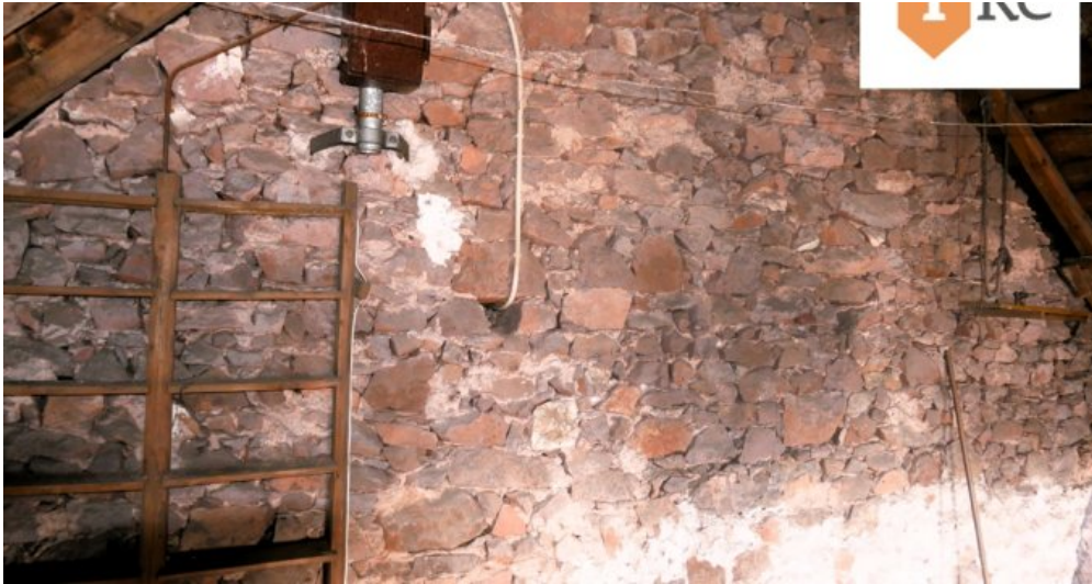
Bruchsteinmauerwerk - Giebel
