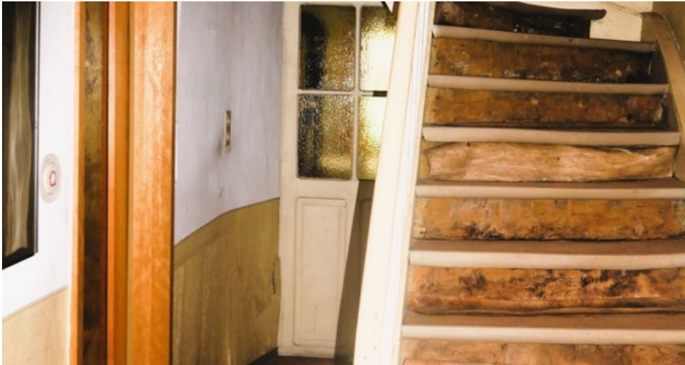
Flur EG mit Treppe zum OG
