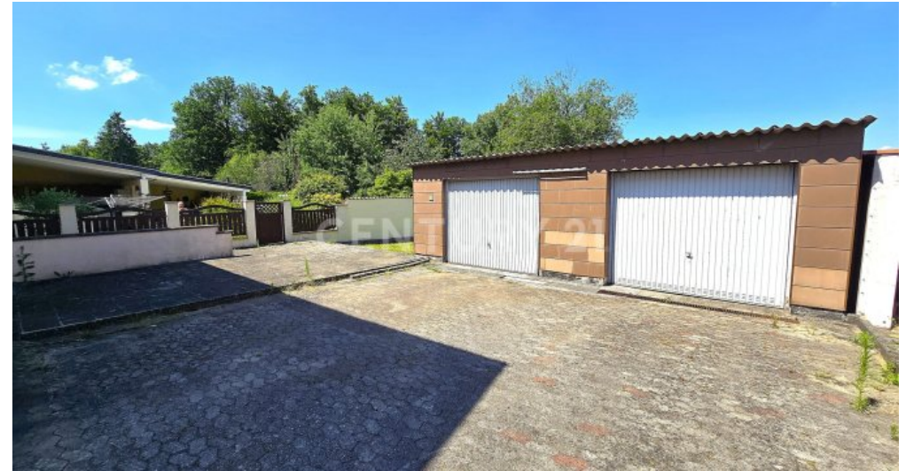
Doppelgarage mit Stellplätzen davor.
