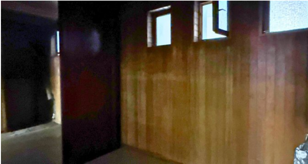
Ehemalige Sauna EG
