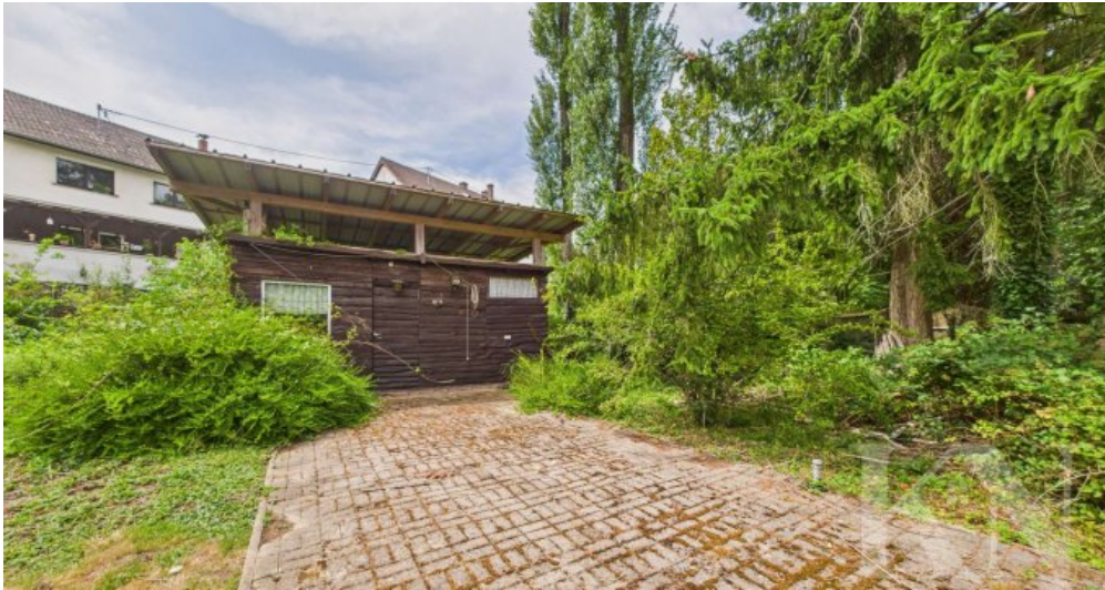
Gartenhaus auf dem Grundstück
