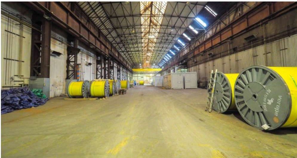
Industriehalle mit Kranbahn
