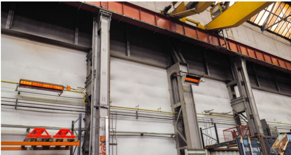
Industriehalle mit Kranbahn
