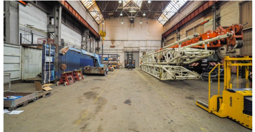
Industriehalle mit Kranbahn
