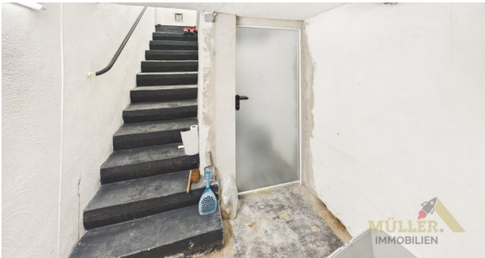
Treppe in Keller und Vorraum
