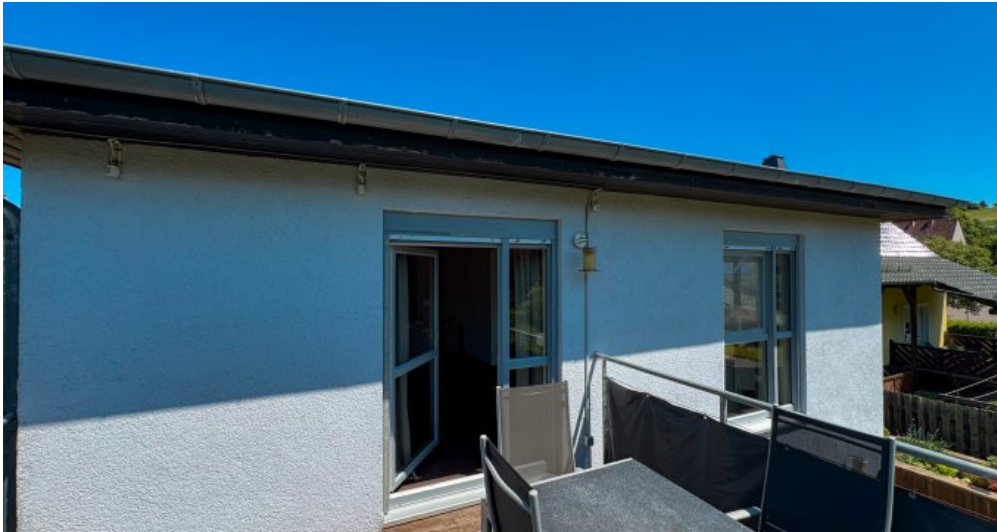
Ansicht Fassade von Balkon
