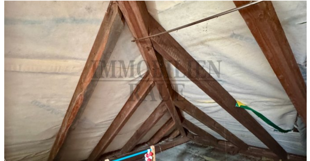
Abstellraum im DG
