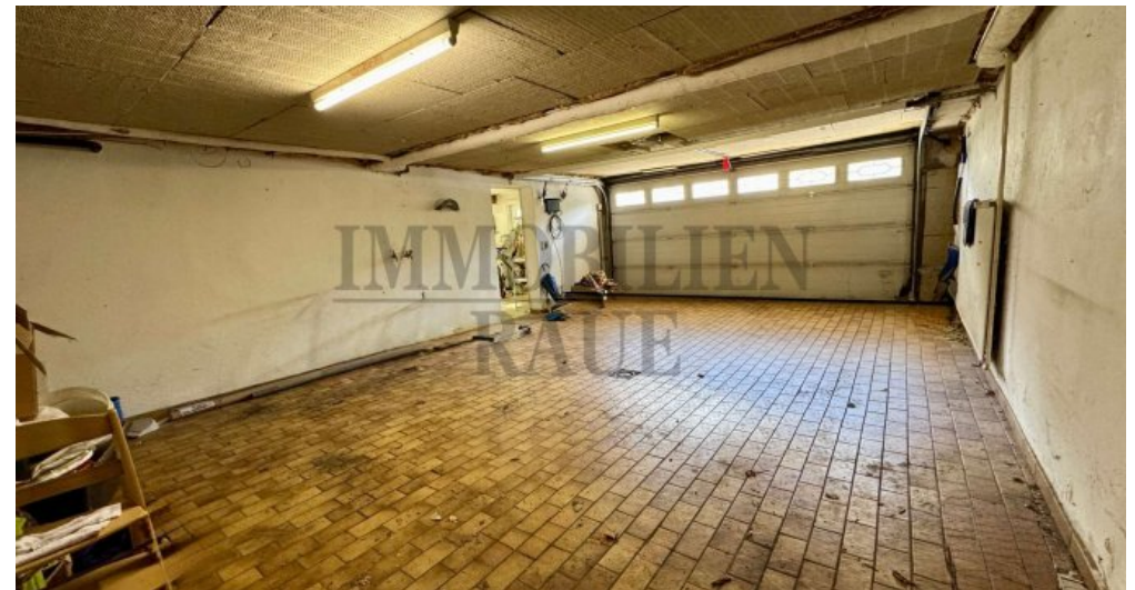
Doppelgarage im Haus
