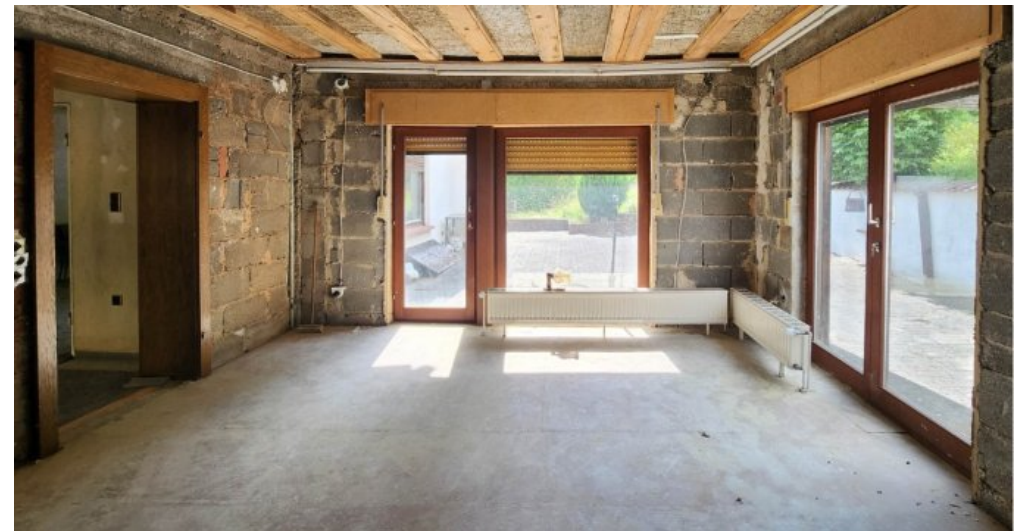
EG Anbau mit bodentiefen Fenstern und Zugang zu Terrasse und Garten
