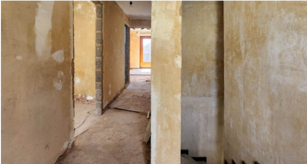
Flur im Obergeschoss
