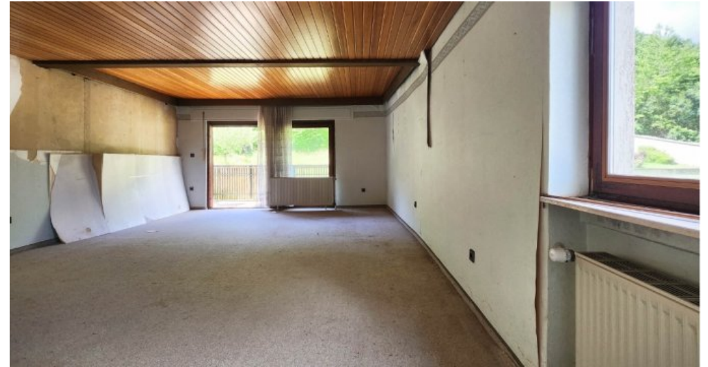
Zimmer/Anbau mit Zugang zum rückwärtigen Balkon im Obergeschoss
