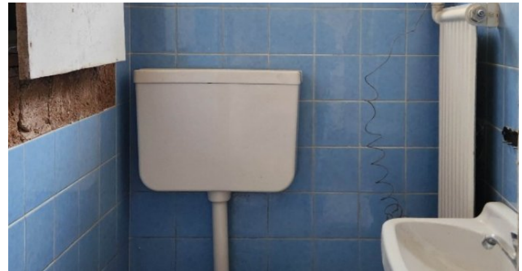
Gäste-WC mit Fenster im Erdgeschoss
