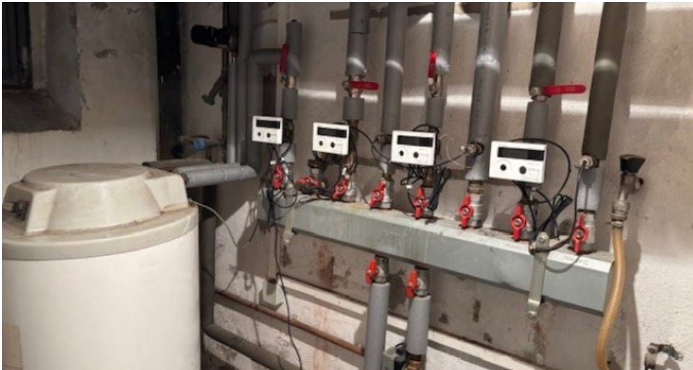
Heizungszähler getrennt
