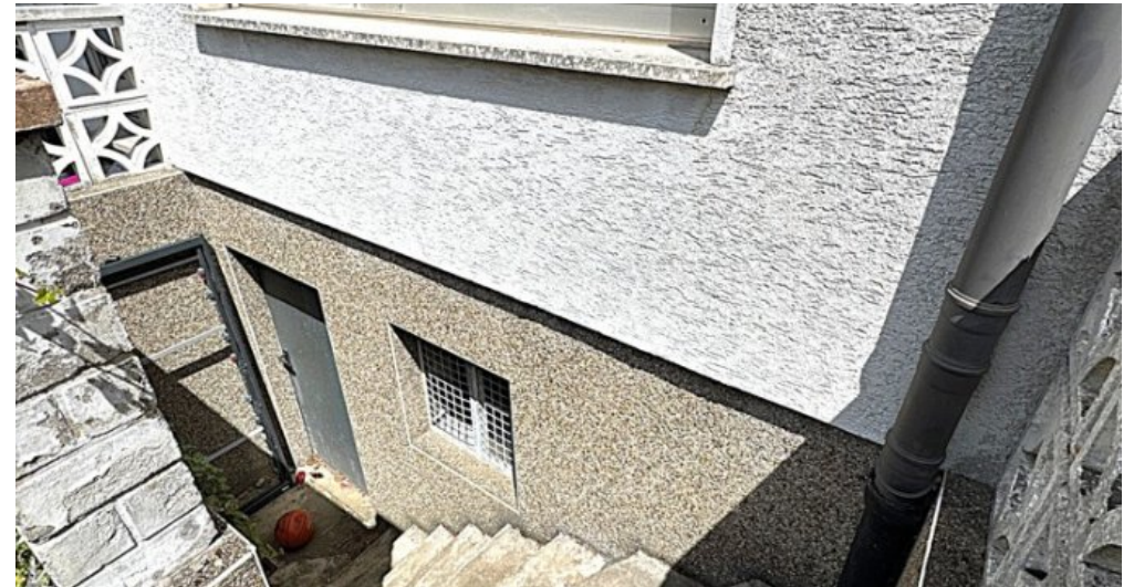
Zugang zum Keller
