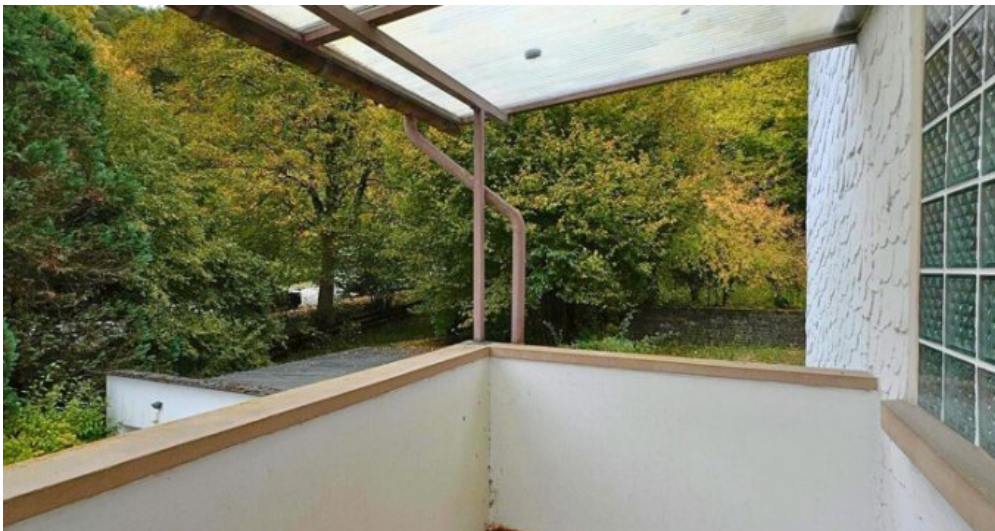
Überdachter Balkon OG
