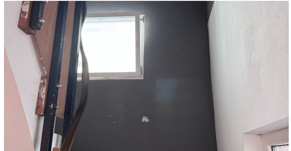
Wohnung EG Treppenaufgang
