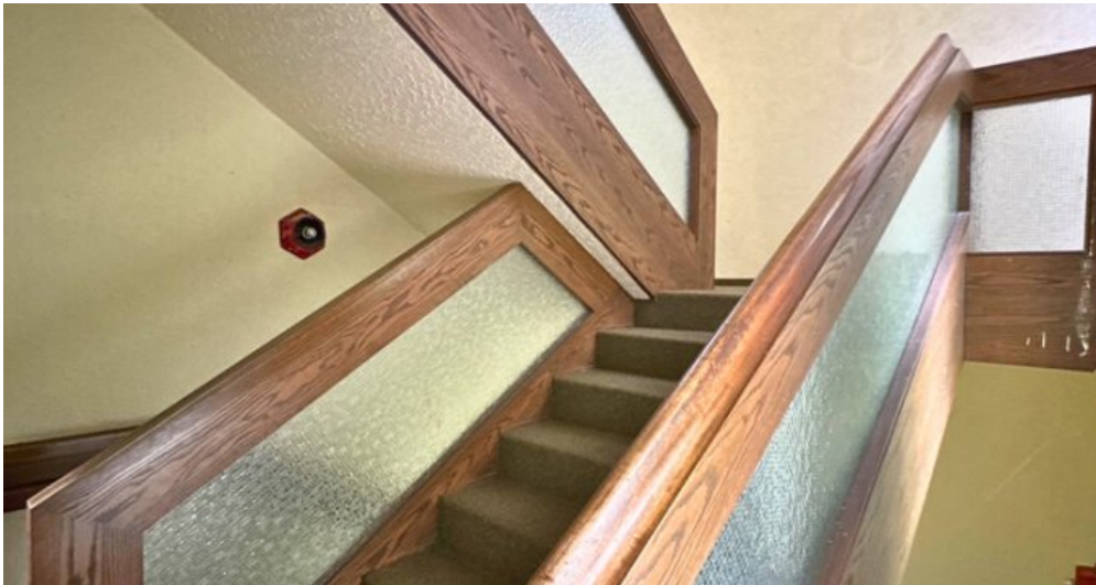
Treppe zum 2.OG
