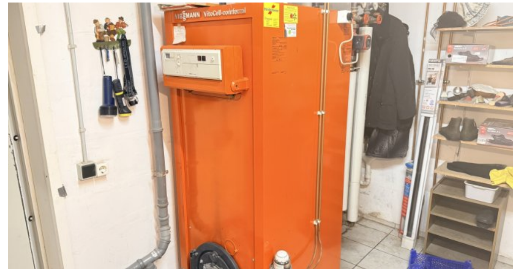
Viessmann Ölzentralheizung
