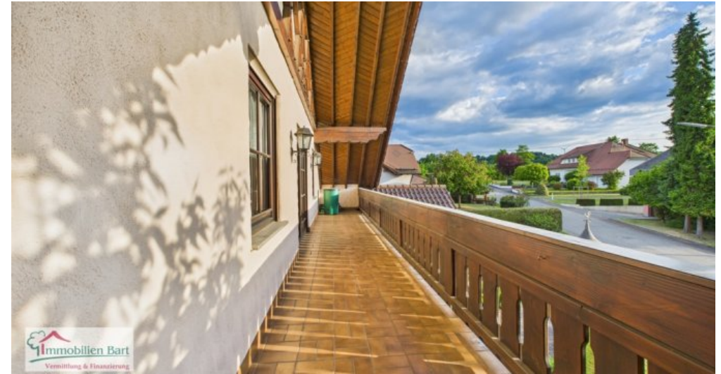
überdachter Balkon Westseite
