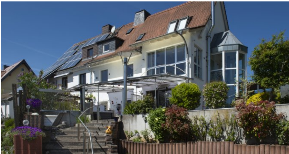
Ansicht von hinten
