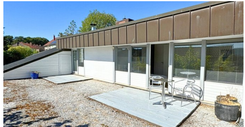
Ansicht Dachterrasse OG
