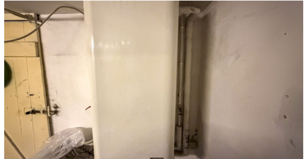
elektrische Warmwasseraufbereitung
