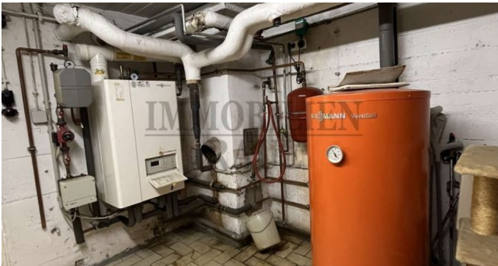
Gas-Zentralheizung (Brennwertgerät)
