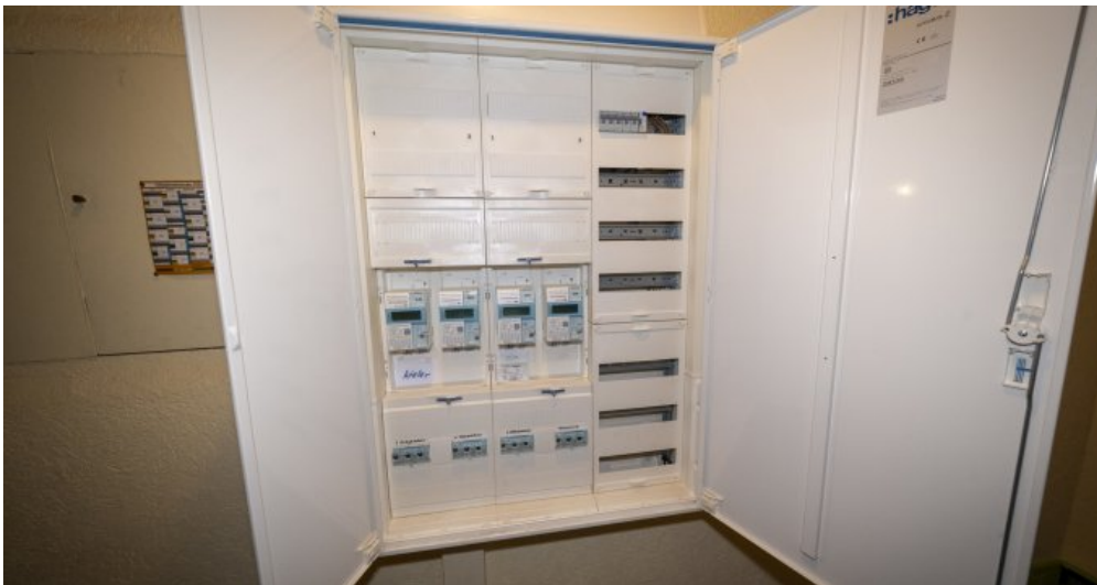
Sicherungskasten
