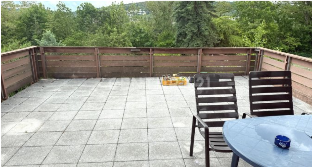
Terasse über Garage EG
