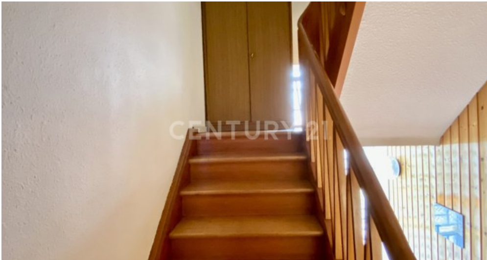
Zugang zum ausbaubaren Dachboden
