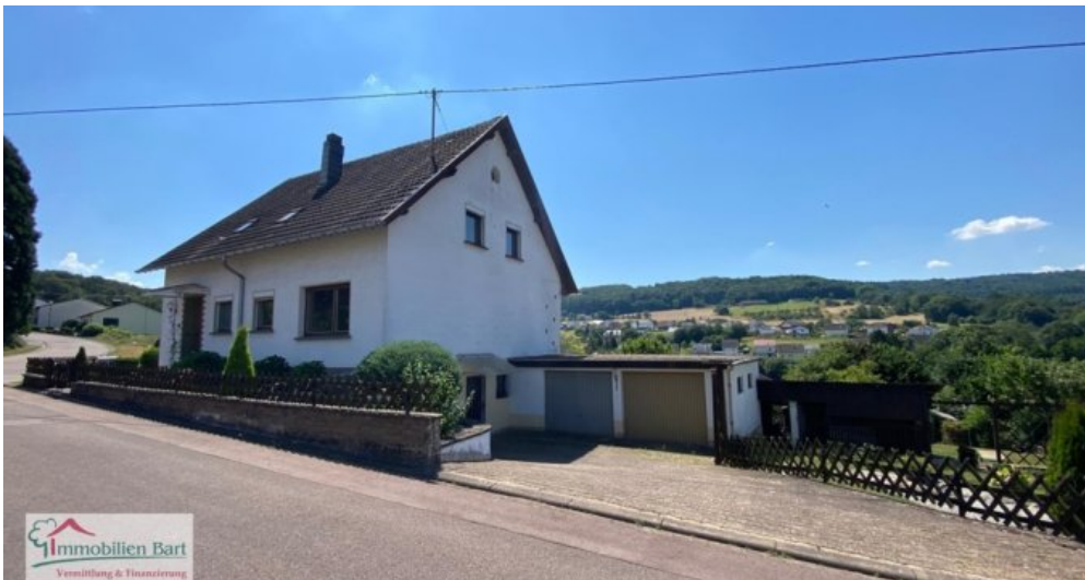
Seitenansicht mit Garagen
