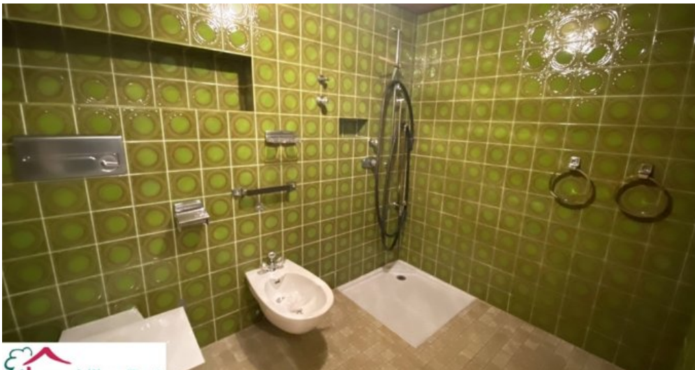
Schwimmbereich: Dusche + Sanitär
