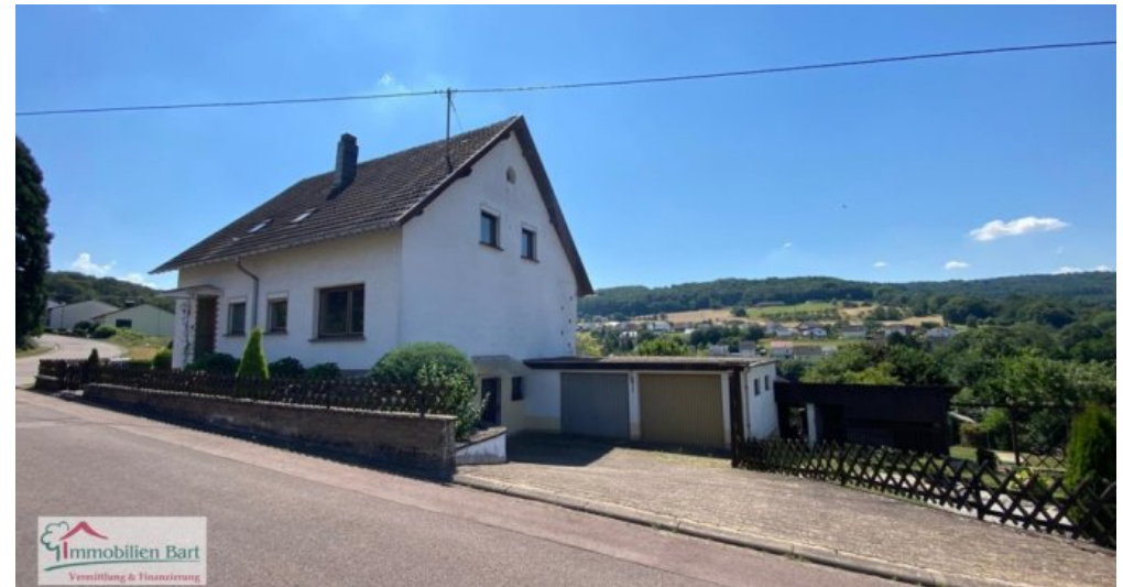
Seitenansicht mit Garagen
