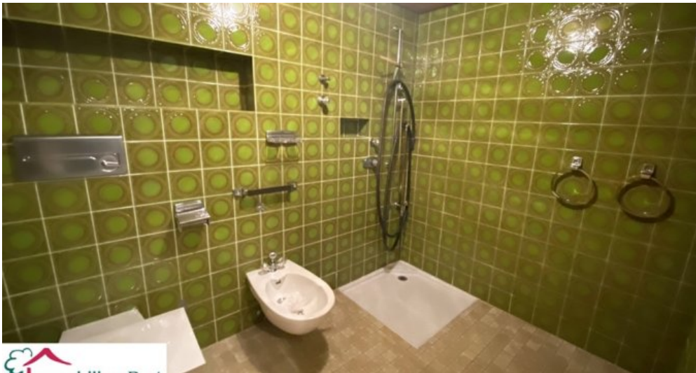
Schwimmbereich: Dusche + Sanitär
