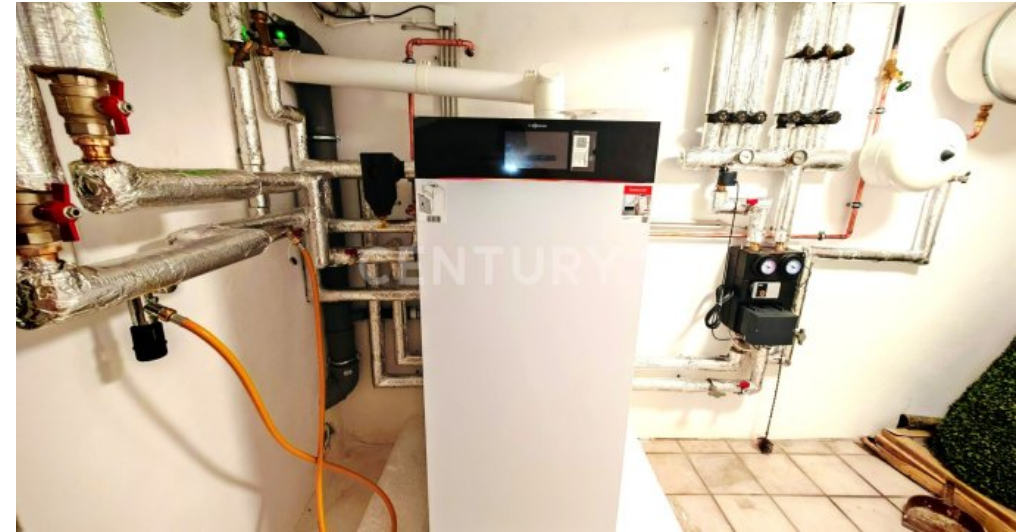
Niegelnagel Neue Heizung
