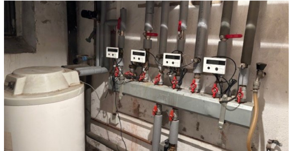
Heizungszähler getrennt
