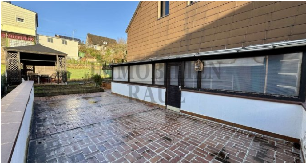
Rückansicht (Terrasse über der Garage)
