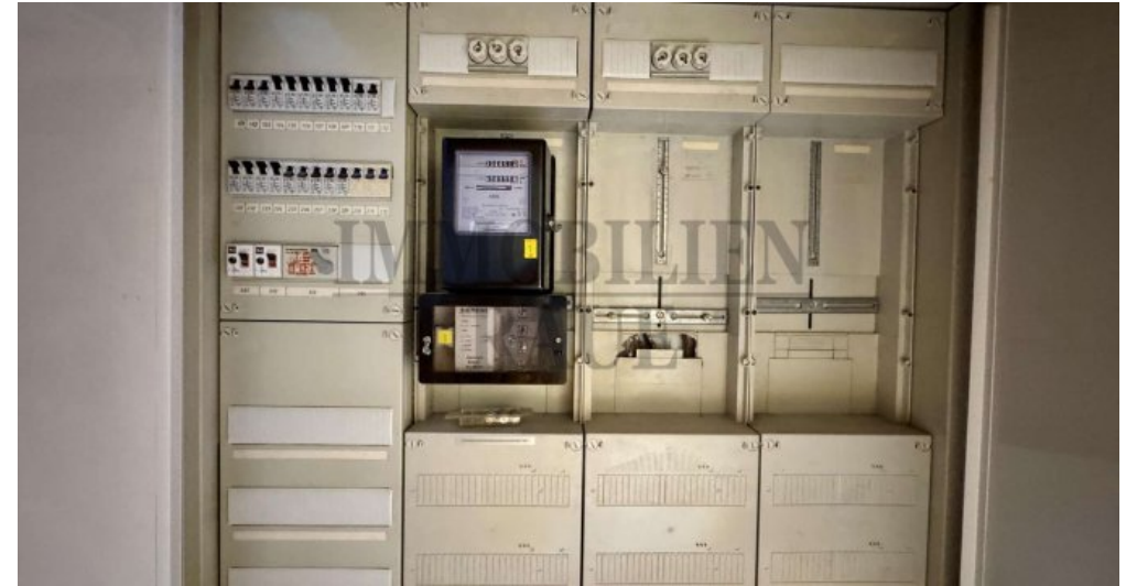
Stromzählerschrank
