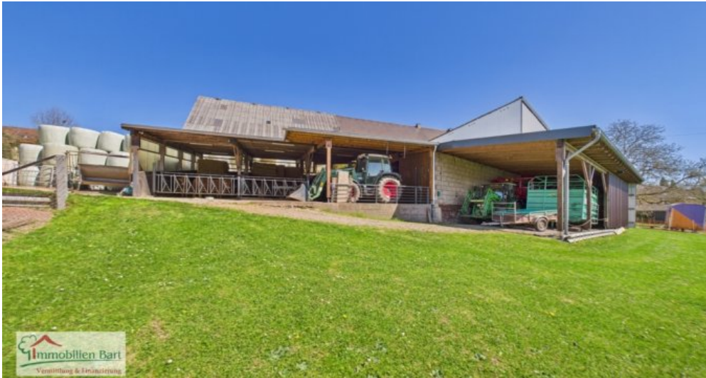
Seitenansicht Garagen u. Stallungen
