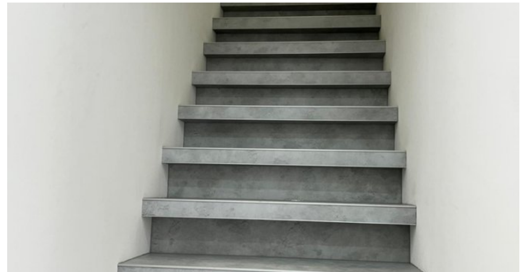
Treppe zum DG
