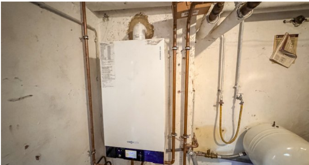
Gas-Brennwertheizung
