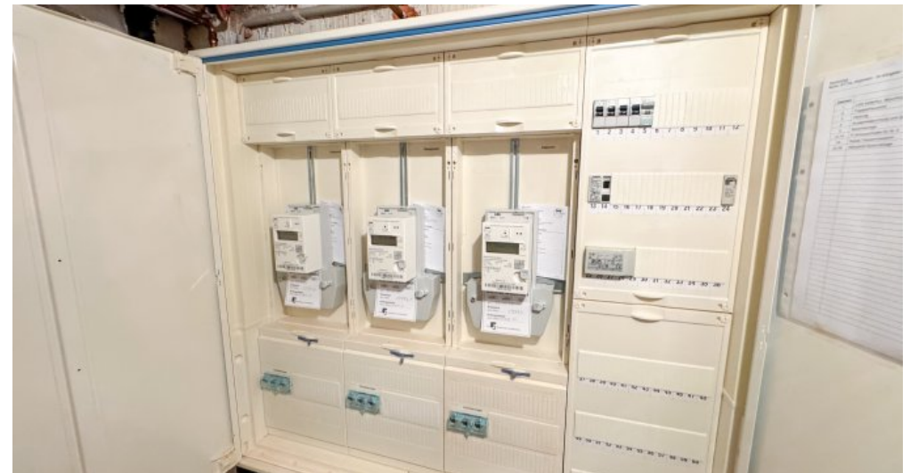
Stromzählerkasten
