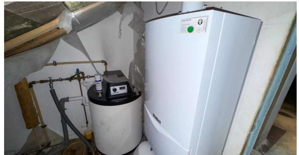
Heizung unterm Dach
