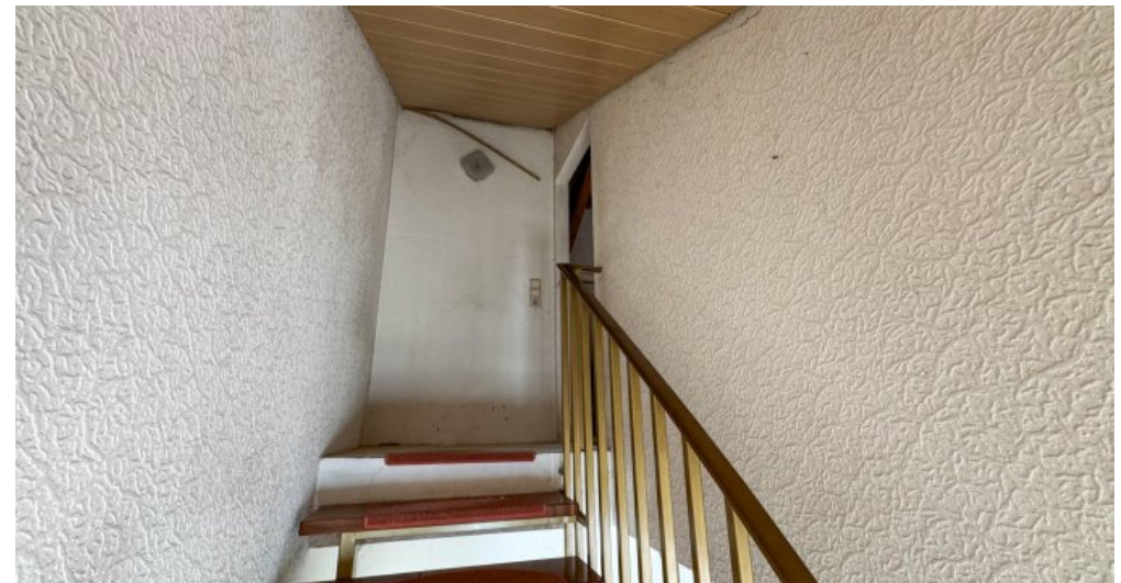
Treppe ins Dachgeschoss
