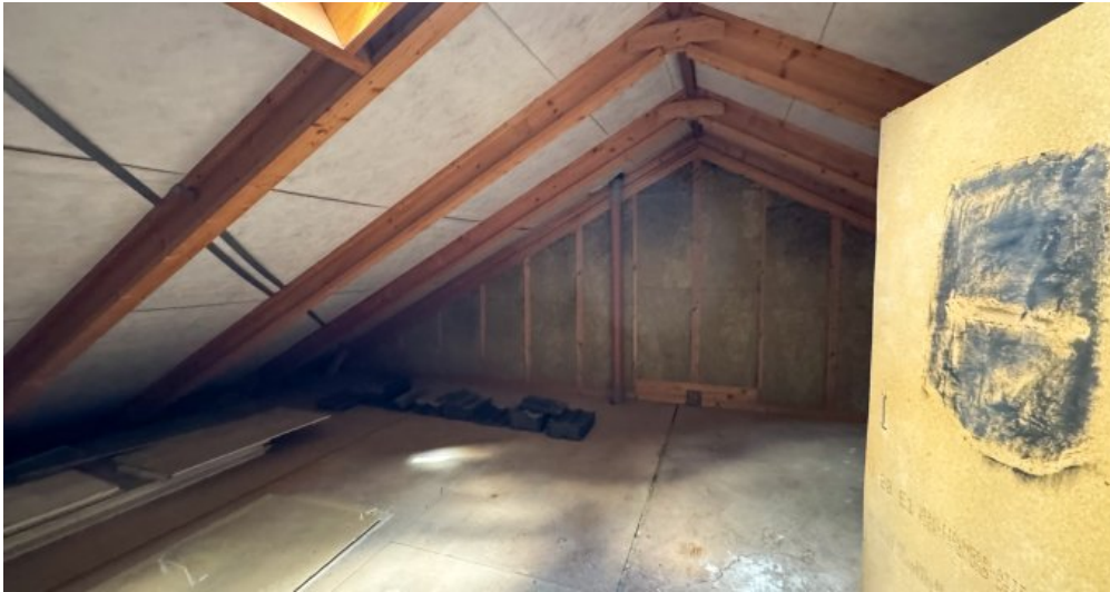
Dachgeschoss nicht ausgebaut
