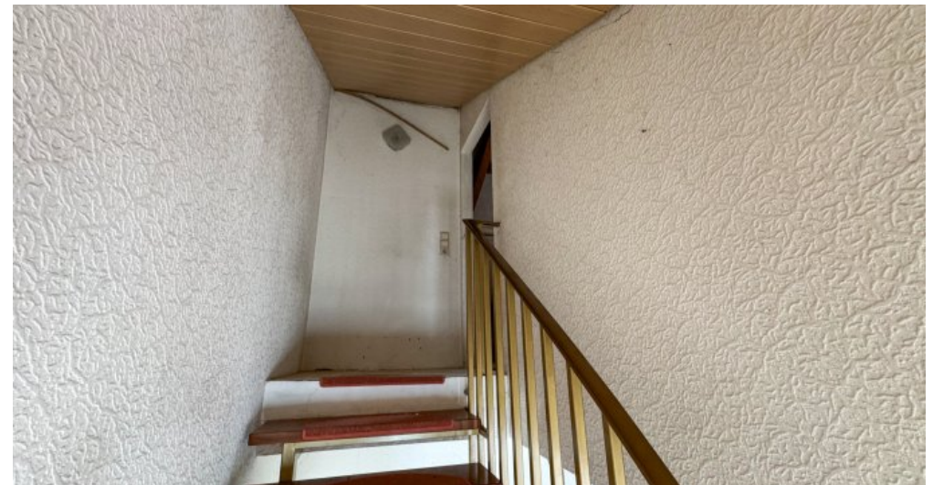
Treppe ins Dachgeschoss
