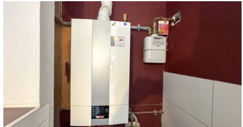
Gas-Brennwertheizung
