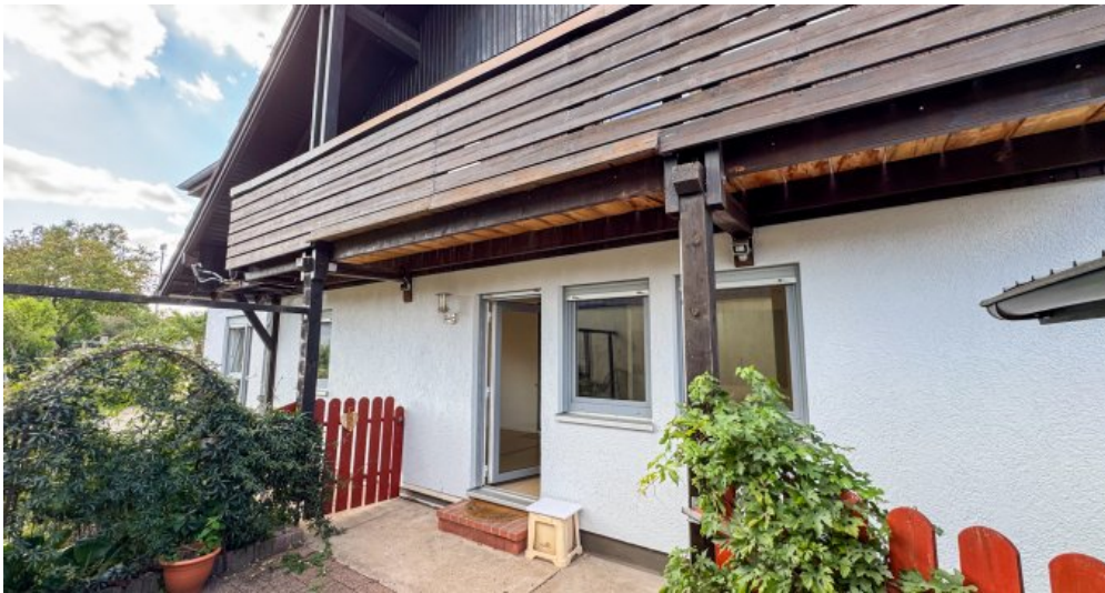
Seitenansicht mit Balkon
