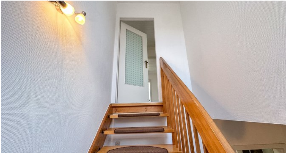
Treppe in Wohnung OG
