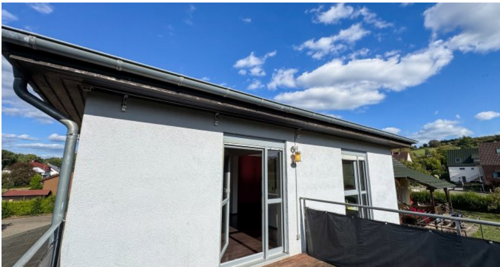
Gebäude Rückseite von Balkon
