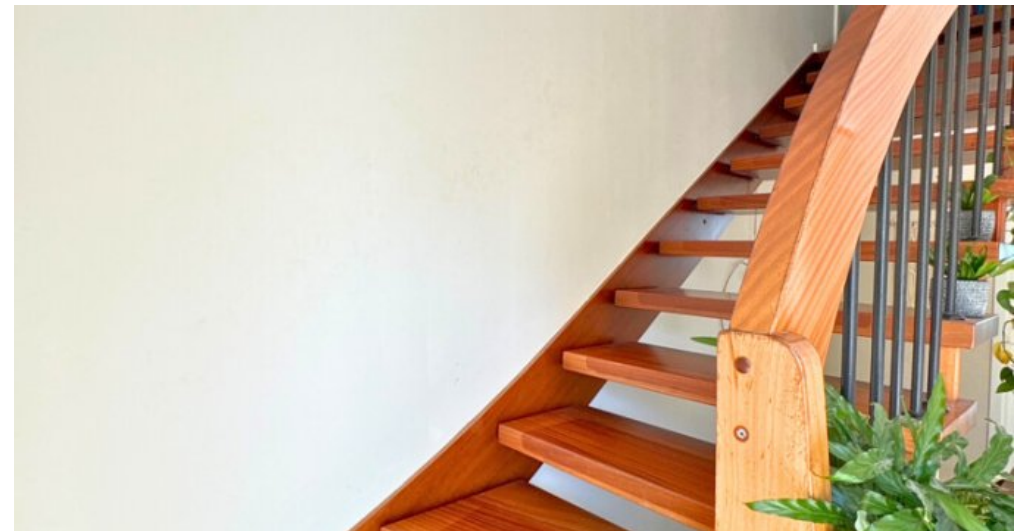
Treppe zum DG
