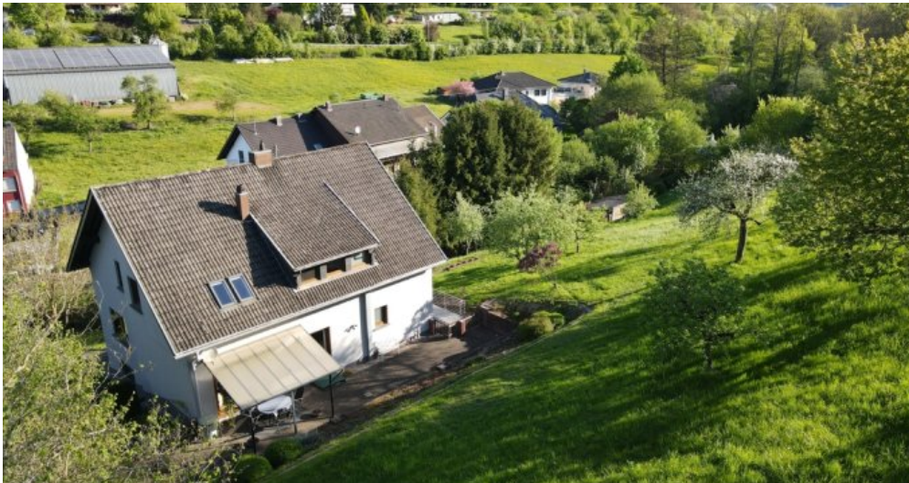
Rückansicht mit Grundstück
