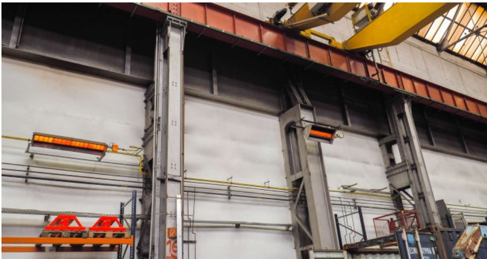
Industriehalle mit Kranbahn
