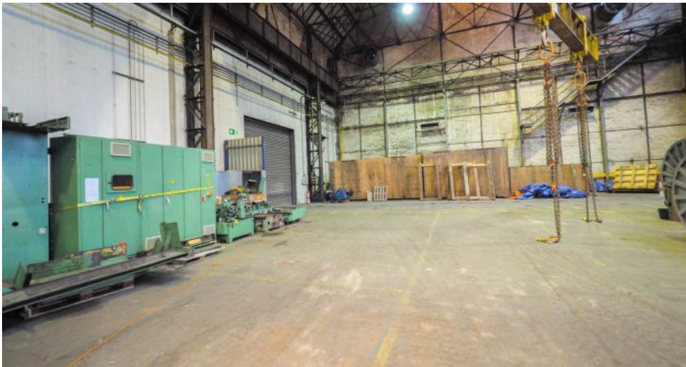
Industriehalle mit Kranbahn
