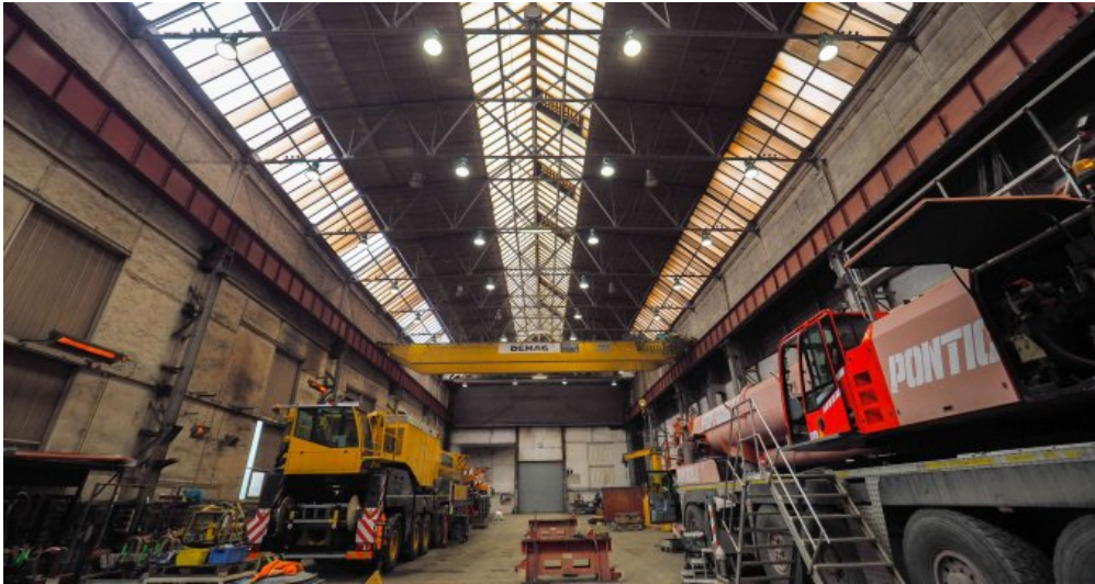
Industriehalle mit Kranbahn
