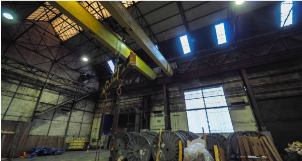
Industriehalle mit Kranbahn
