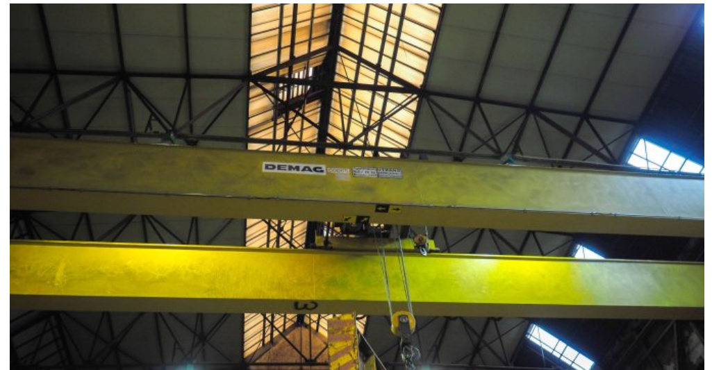
Industriehalle mit Kranbahn
