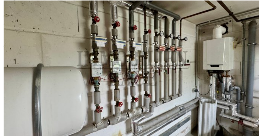
Wärmemengenzähler
