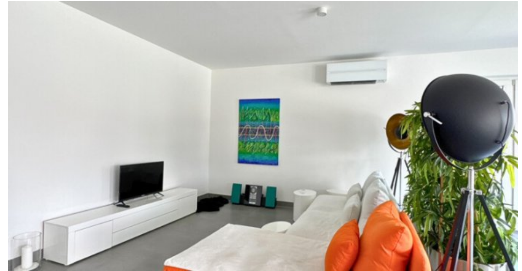
Wohnbereich mit Klimaanlage
