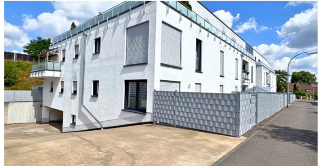
Einfahrt zur Tiefgarage
