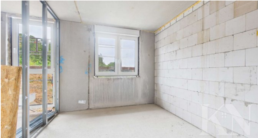
1.5.1. Arbeitszimmer Blick Gesamtraum
