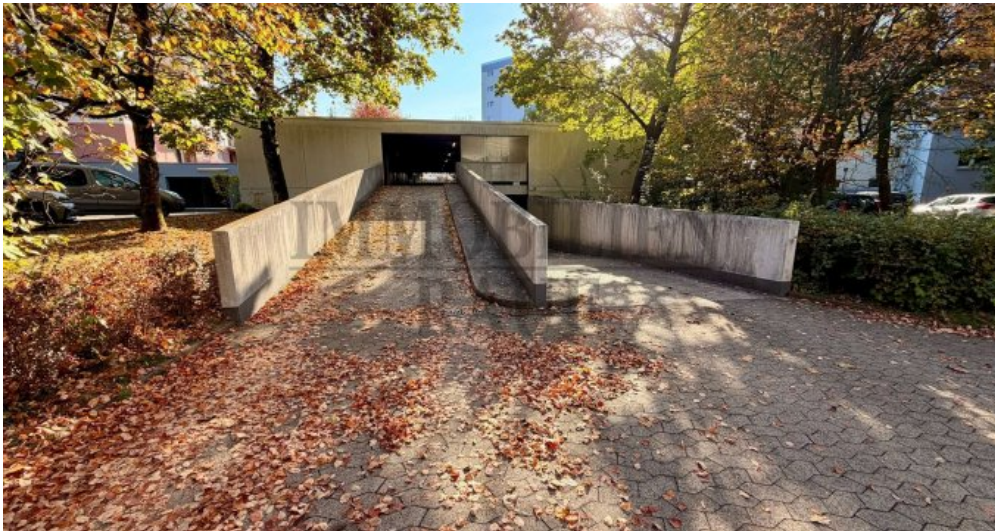
Zufahrt zur Garage
