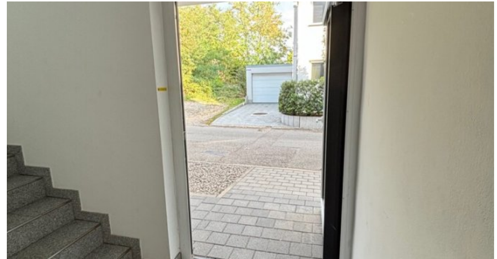
Barrierefreier elektrischer Eingang
