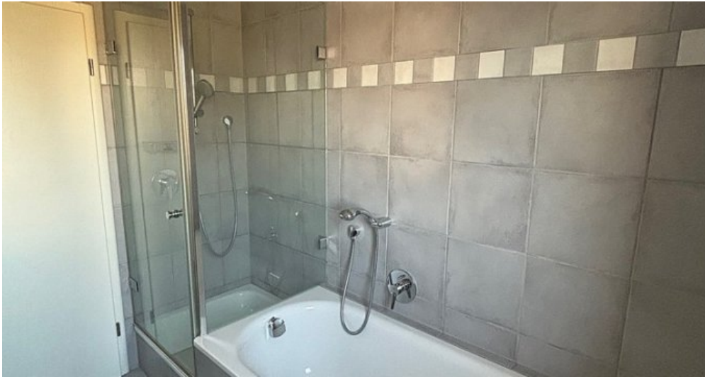
Bad mit Wanne und Dusche
