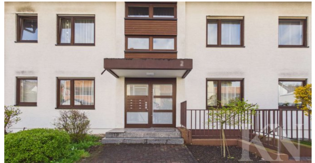
Haus Ansicht Front
