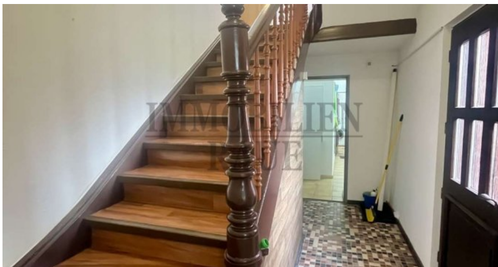
Treppenhaus (zu den Wohnungen)
